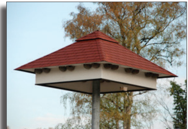
Mehlschwalbenhaus (CEF-Maßnahme) (Foto: T. Prolingheuer)
